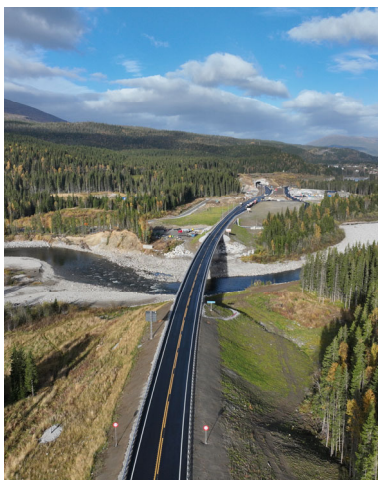
Svenningelva bru som ble bygd først av de store elvekryssingene
