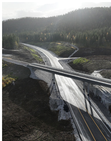
Ny bru for Nordlandsbanen hvor ny E6 krysser under
