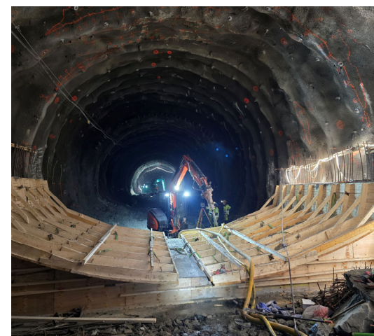
Løsmassesonen som viste seg å være ca. 70 meter ble ferdig sikret mars 2025
