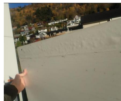
Bilde 24: Plate 13, mykje bobler. Denne plata er delvis under tak på svalgang
