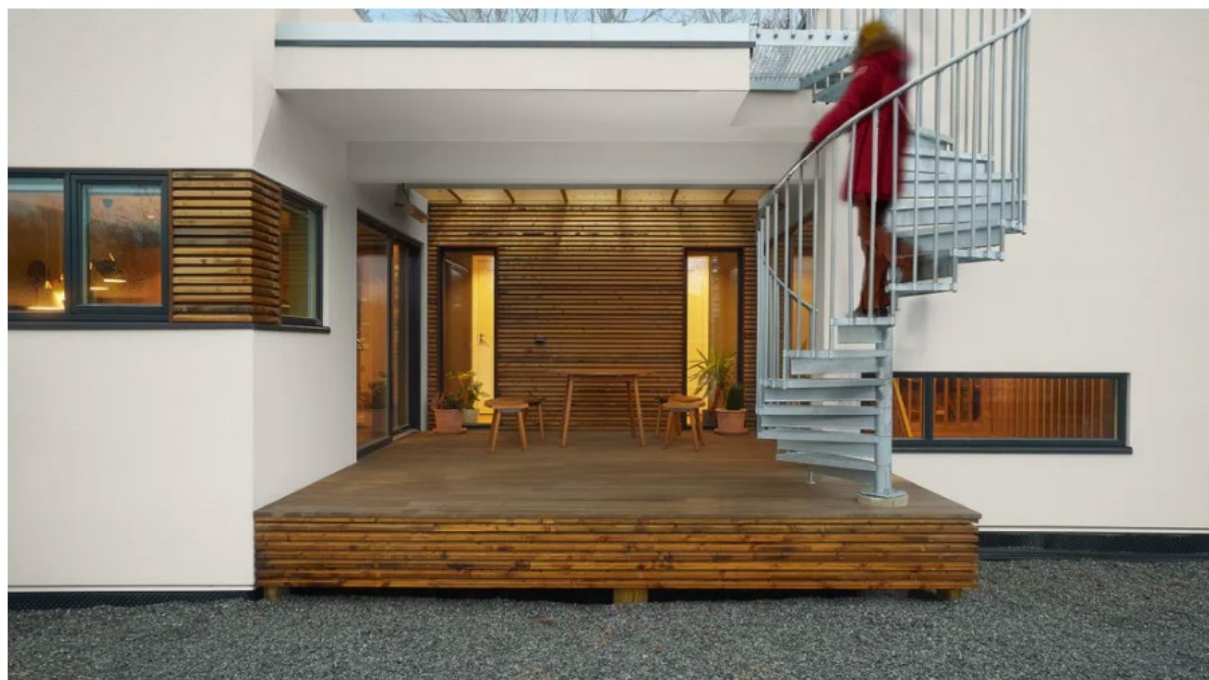
Mur og tre regnes som levedyktige og holdbare materialer. Klimaforandringer og ekstremvær vil kreve mer av materialvalg i årene fremover. Foto: GLAVA/Henning Photo
