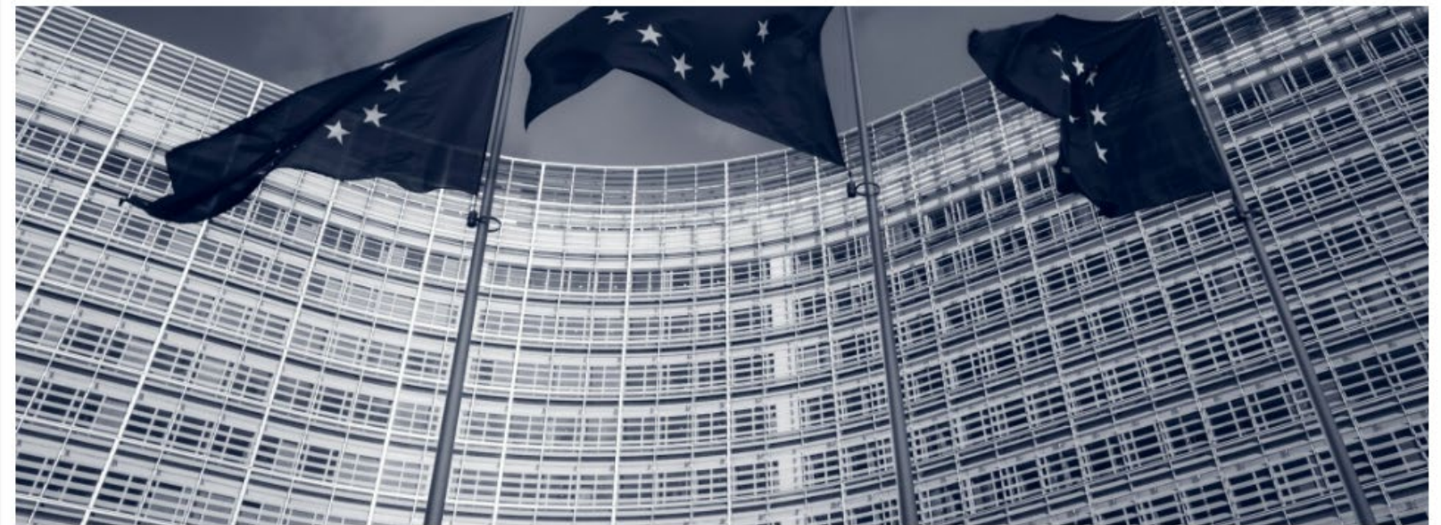
NULLENERGI: Hensikten med EUs taksonomi er at vi både skal bygge mer energieffektivt og at bygg i større grad skal bli energiproducenter. Foto: Christian Lue, Unsplash
